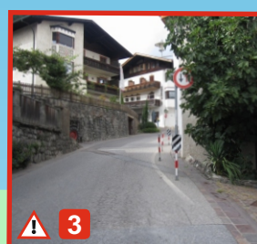
Engstelle Dorfzentrum: Unübersichtlicher Straßenabschnitt. Achtung vor dem Verkehr!
